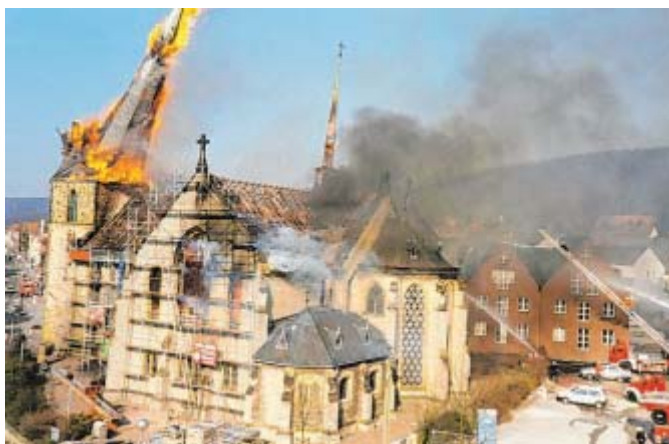
Völlig zerstört: 1990 brennt die Bartholomäuskirche in Brackwede nieder. 1992 eröffnet sie wieder. FOTO: FRANK BECKER
